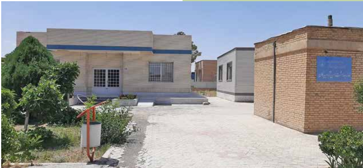
احداث خانه بهداشت حسن آباد تنگ بیدکان با کمک خیران سلامت شهرستان مبارکه
